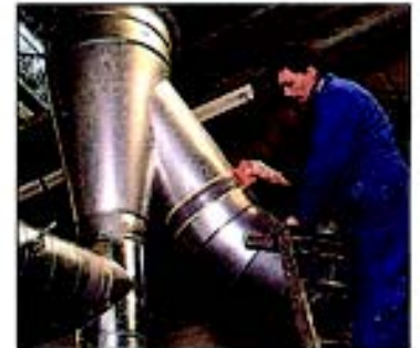
SELLADO DE CONDUCTOS DIVIDIDOS
