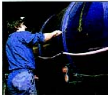
SELLADO DE TANQUES CON FILTRACIONES
