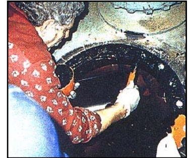
REPARACION DE FORROS DE CAUCHO
