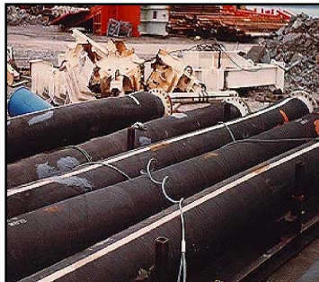
REPARACION DE MANGUERAS FLOTANTES
