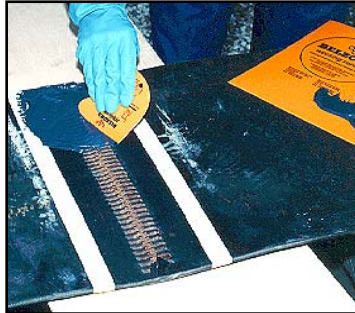
SELLADO DE UNIONES METALICAS
