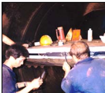
RECONSTRUYENDO ASIENTOS DE VALVULAS
