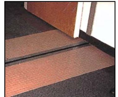
REPARACION DE CUBIERTAS DE CABLES
