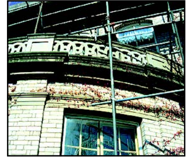
OBRAS DE MAMPOSTERIA
