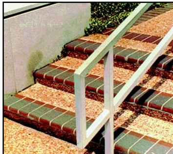
NIVELACIÓN DE ESCALONES
