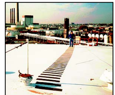
RECONSTRUCCIÓN DE CANALETAS
